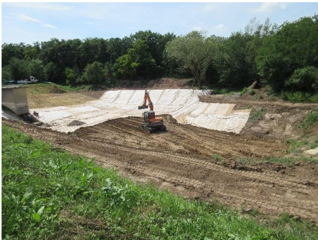
M.7.3 – 6. ábra: Bányavíz havaria tározó építése
