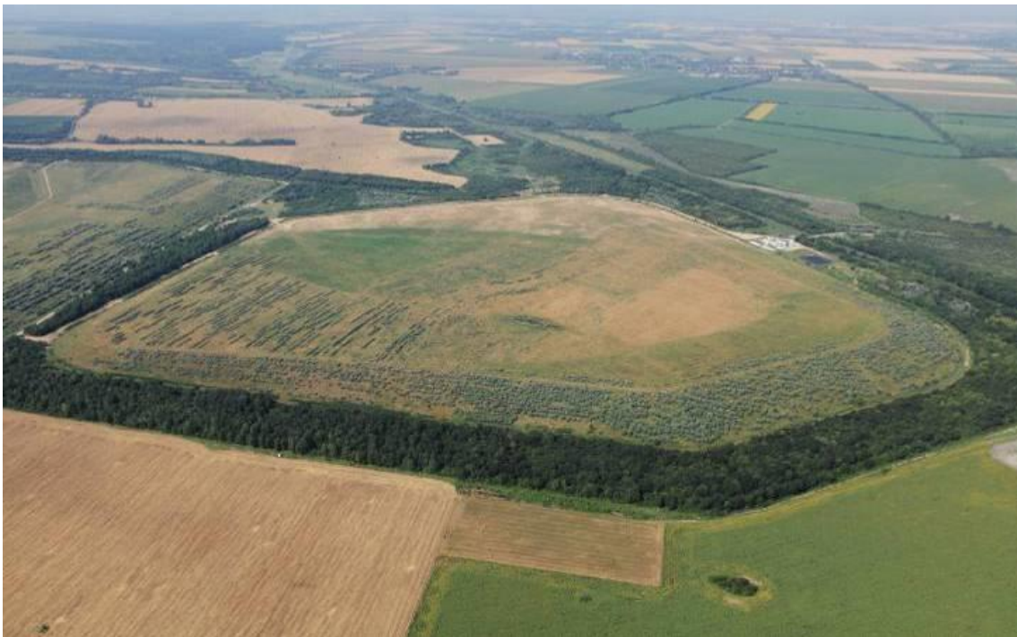
M.7.3 – 8. ábra Rekultivált uránipari zagyártározó
