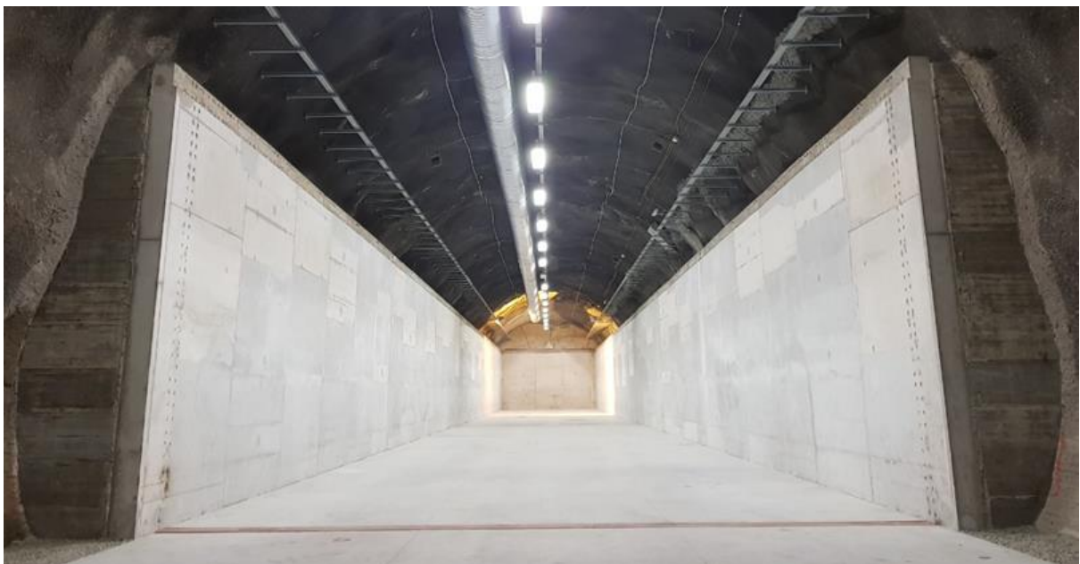
H.3 – 4. ábra Vasbeton medence a Nemzeti Radioaktív hulladék-tároló I-K2 tárolókamrájában
