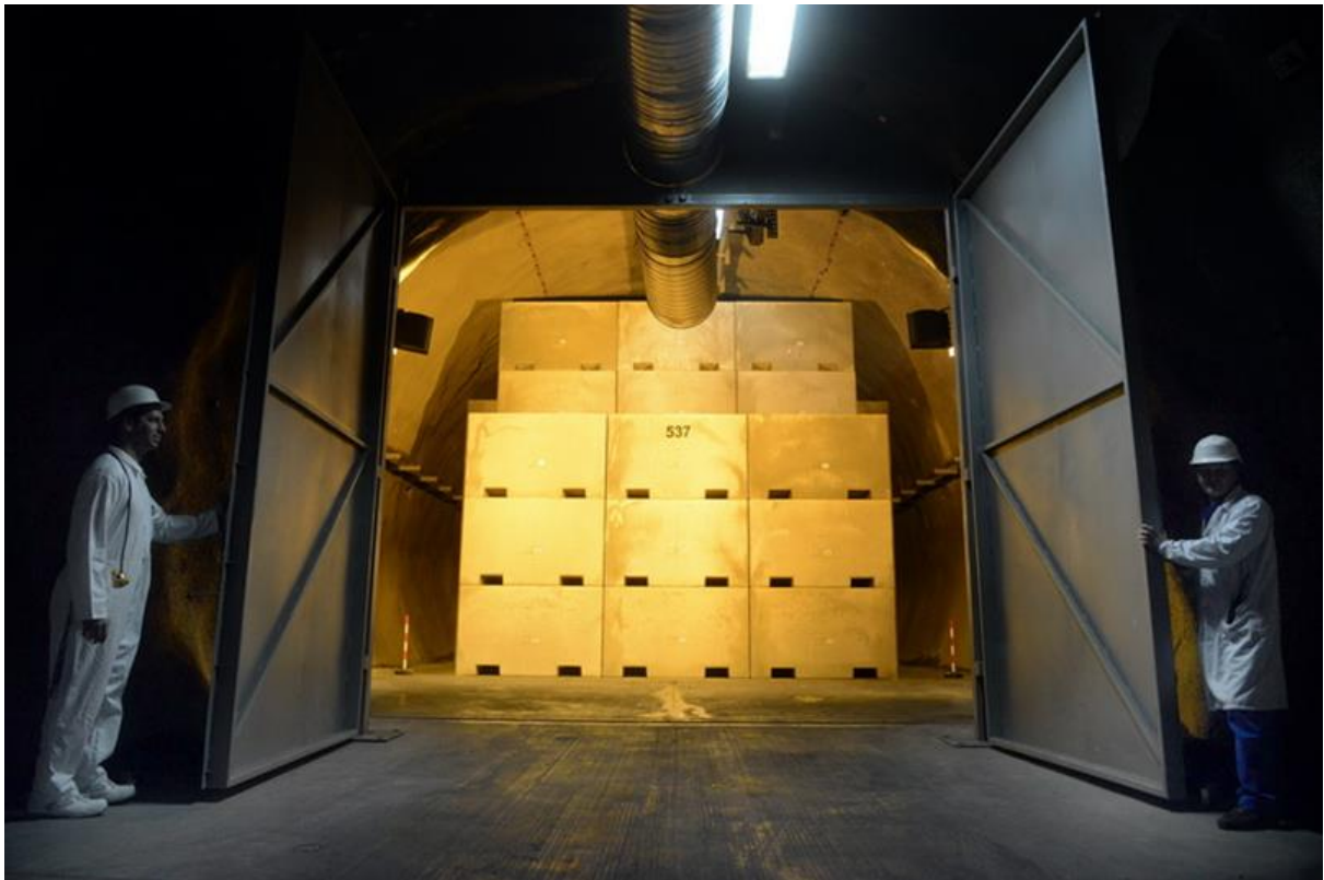
H.3 – 3. ábra A megtelt I-K1 tárolókamra a Nemzeti Radioaktív hulladék-tárolóban
