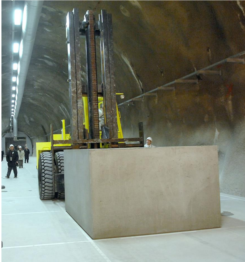
H.3 – 2. ábra Az első vasbeton konténer elhelyezése a Nemzeti Radioaktív hulladék-tárolóban
