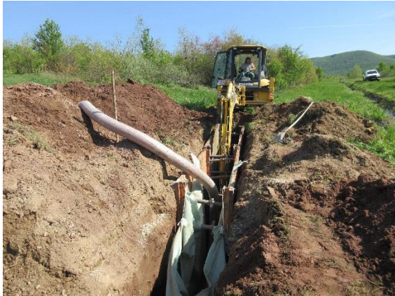
M.7.3 – 5. ábra: Meddőhányó drénszivárgó rendszer építése
